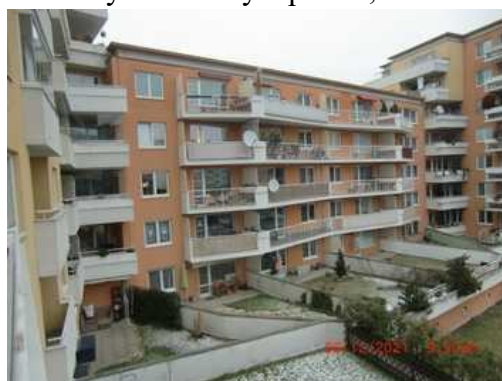
Bytové domy č.p. 852, 853
