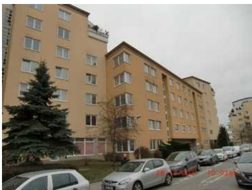
Bytové domy č.p. 852, 853
