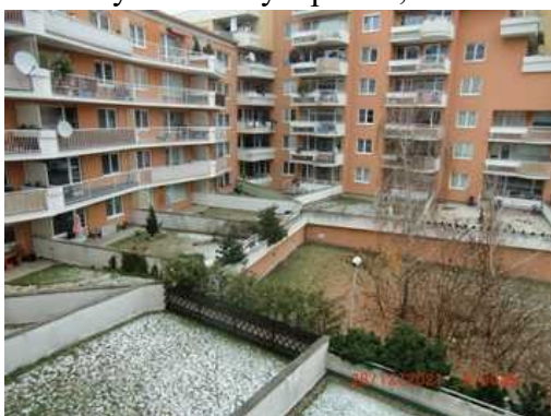
Bytové domy č.p. 852, 853
