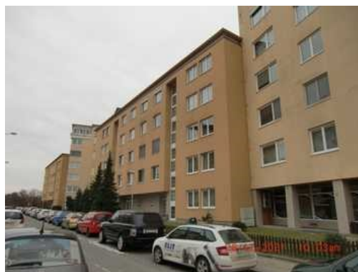
Bytové domy č.p. 852, 853
